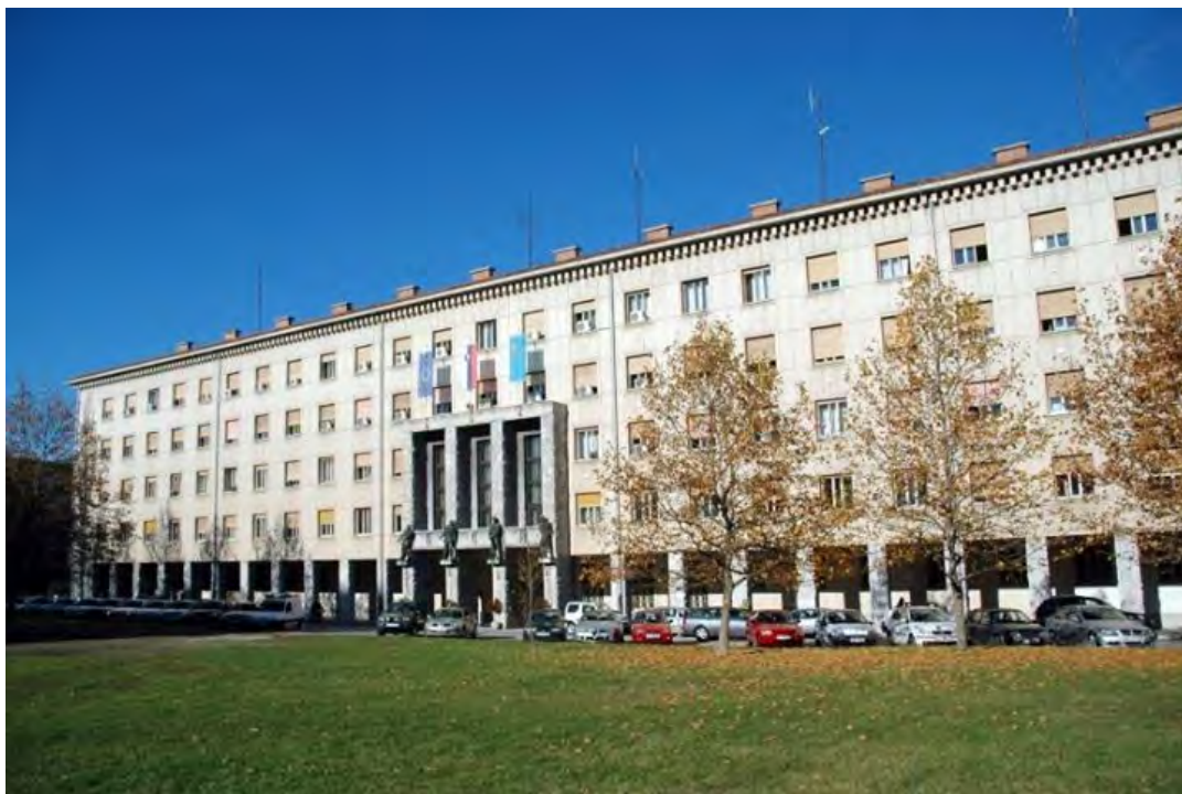
Figure 5. 59: Facade of the Municipality of Nova Gorica - Občina.
