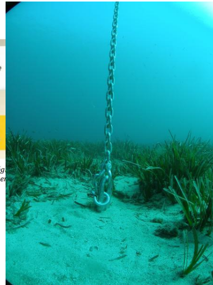
Figura 6. Taco químico. Fuente: "Proyecto Técnico para la instalación de boyas de amarre en la reserva marina de Tabarca" Grupo Tragsa.
