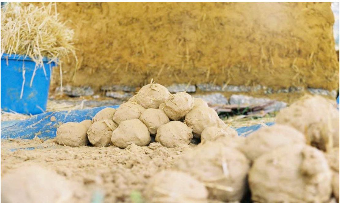
Fig. 19. Cob balls
