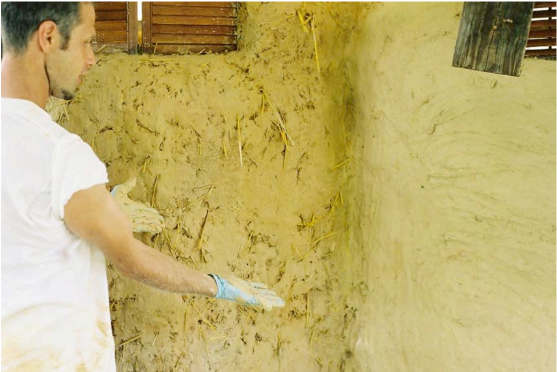
Fig. 28. Scratch coat: Final coat
